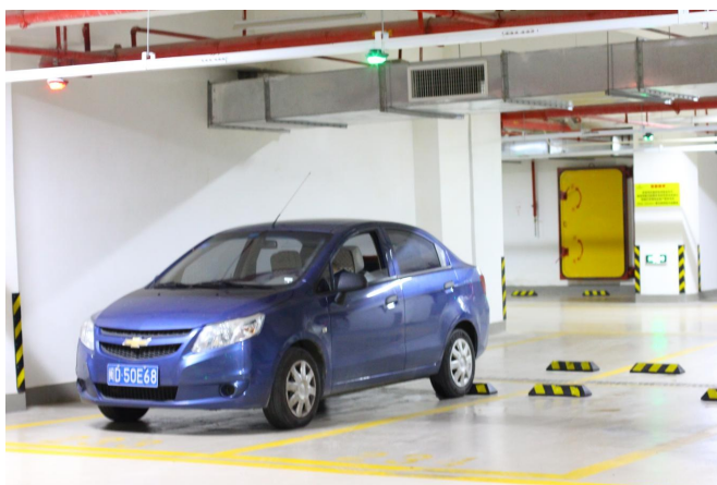
Esempio di installazione: sensore con indicatore integrato sopra ogni posto auto
